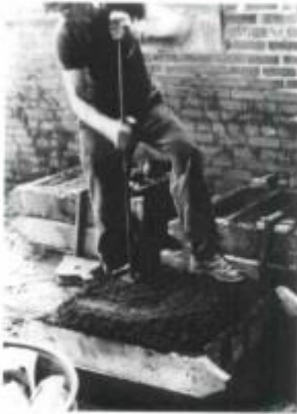
Fig. 3. Le tassage du sable à l'aide de gros caissons
